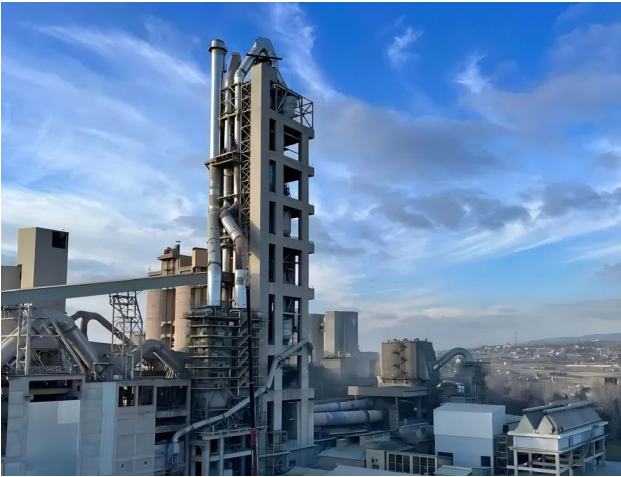
凯盛节能总承包的法国 VICAT 集团所属 BASTAS 水泥厂配套 15MW 空冷余热发电项目顺利通过工程验收
