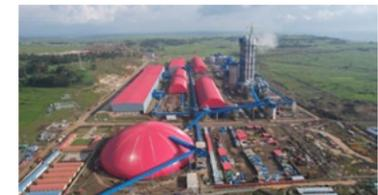
埃及 WNCC 水泥窑替代燃料利用系统，替代燃料达 25t/h，每年减少化石燃料消耗量 7.5 万吨标煤，减排二氧化碳约 20.6 万吨。
