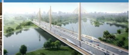
2024年5月，中复碳芯助力的沔阳大桥全面通车。沔阳大桥所采用的碳纤维拉索，是目前世界最大规格的碳纤维拉索，一束碳纤维索由253根保证强度2800MPa的直径7毫米碳棒束成型，锚固力高达2000吨。这一技术的应用，不仅展示了我国在桥梁建设领域的先进技术和实力，也为全球桥梁建设提供了新的思路 and 方向。
