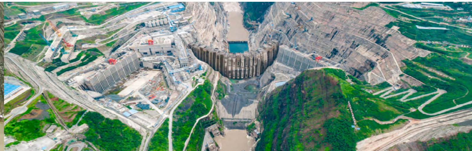
中国建材总院低热水泥助力白鹤滩水电站打造“无缝大坝”
