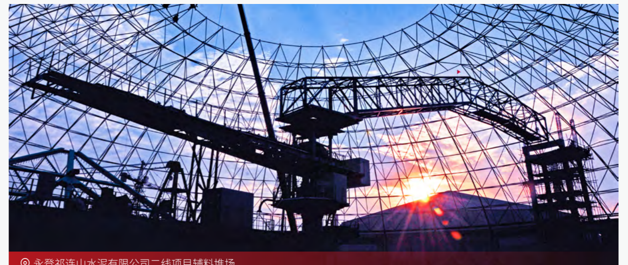
永登祁连山水泥有限公司二线项目辅料堆场
