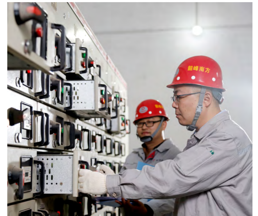
湖南韶峰南方水泥有限公司员工在电气室检查设备情况
