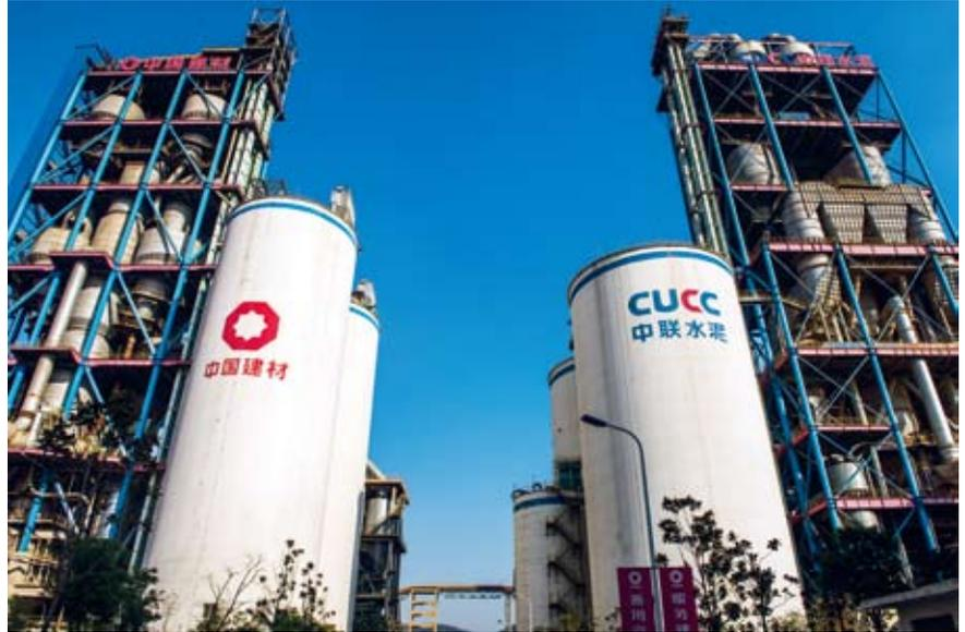
新型干法水泥技术是指以悬浮预热和预分解技术为核心，利用现代流体力学、燃烧动力学、热工学、计算流体力学、分体工学等现代科学理论和技术，并采用计算机及其网络化信息技术进行水泥工业生产的综合技术。其特点是：生产大型化、自动化，符合清洁生产的要求、能实现废弃物再利用、减少环境负荷。
