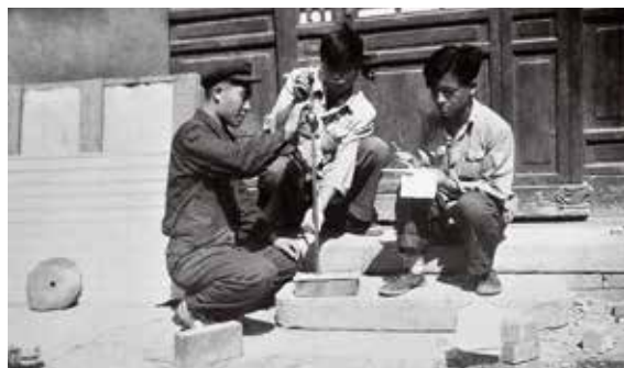
在旋马下湾研究所试验室外，技术人员在做粘土砖撞痕试验
