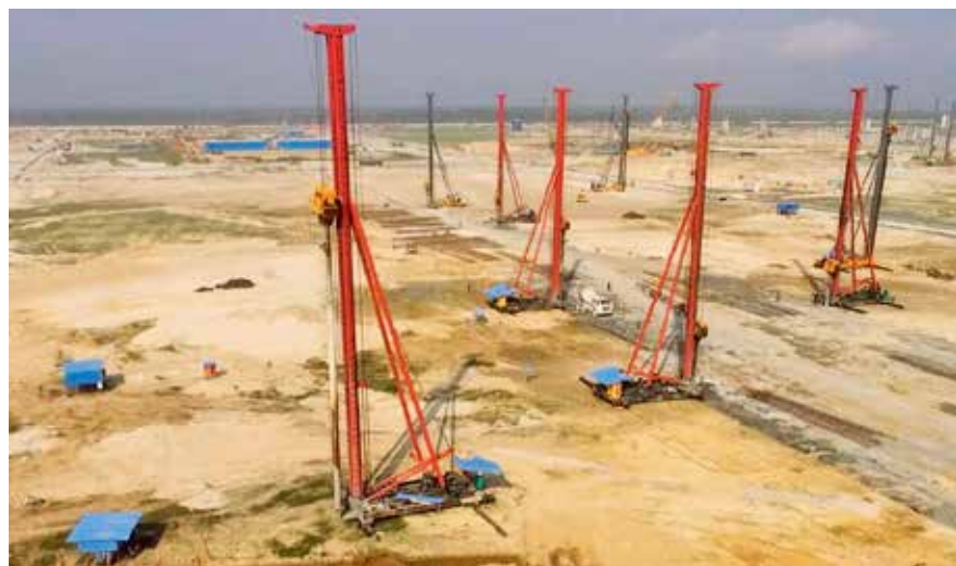
尼日利亚丹格特炼化厂水池桩基工程
