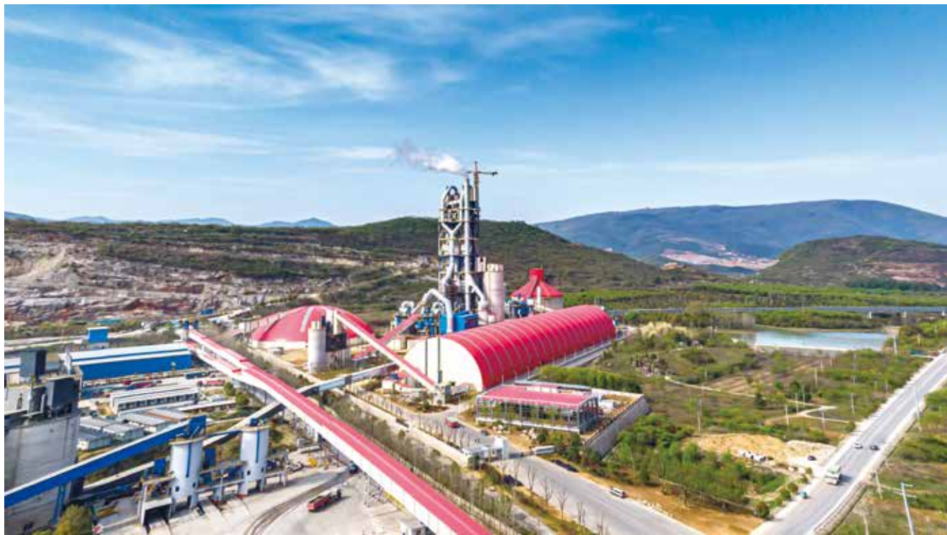
槐坎南方日产7500吨优化升级项目全景
