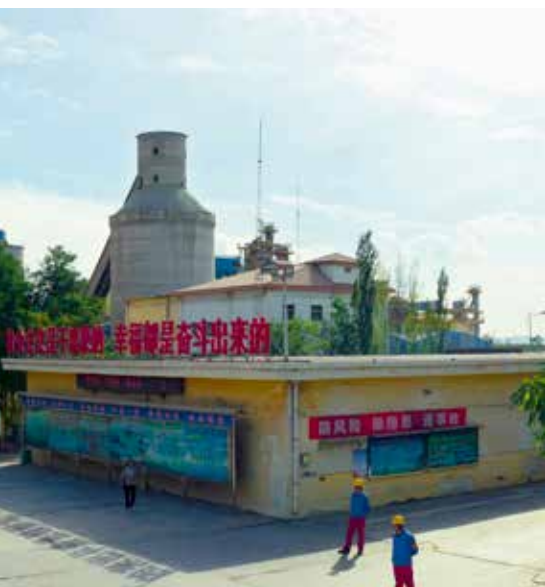
青铜峡生产区全景
