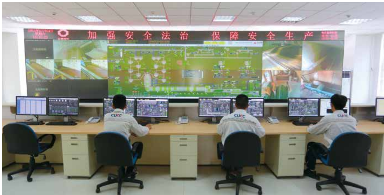
槐坎南方熟料生产线监控调度中心
