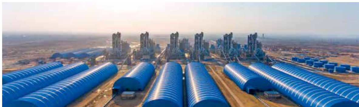
埃及GOE六条日产6000吨水泥线
