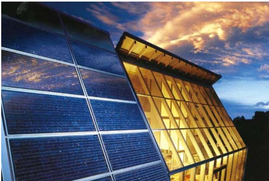
原来的幕墙。这样既可以做建材，又可以发电，进一步降低了光伏发电的成本。可以直接用电池组件做建筑材料，如将单晶硅、多晶硅封装到瓦状的电池板中，用来做光伏瓦，将薄膜电池与卷材复合为光伏卷材，可以实现光伏和建筑更深层次的结合。光伏发电无噪声，不需要燃料，没有废弃物排放，与建筑物结合不会给居民带来任何不便，人们比较容易接受。另外，光伏与建筑相结合可以实现发出的电力就地上网，不用额外架设输电线路，可减少输电线路的投资和损失，替代部分建筑材料。
